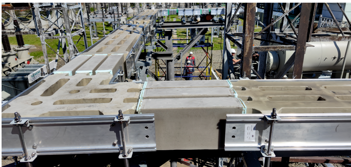
Пример. Процесс демонтажа токопровода на объекте
